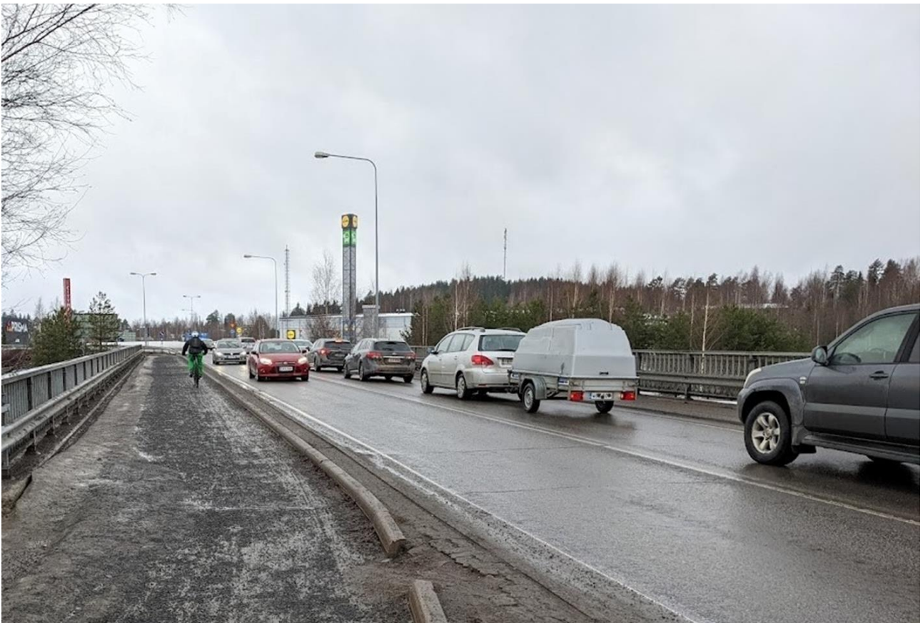
Palokanorren silta, joka ylittää nelostien. Kovin kapea silta kolmelle autokaistalle, jotka ns. ensimmäisen vaiheen parannussuunnitelmassa on tähän piirretty.
